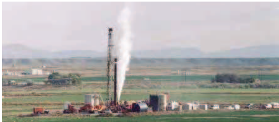
Figure 32 : Fuite de gaz dans un puits d'extraction à Marcellus Shale. (Source: powderriverbasin.org)
